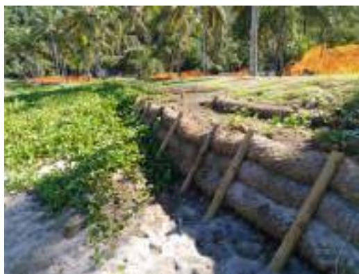
Figure 6: Clichés des boudins cocos et enrochements libres dans le cadre du chantier de l'arrière-plage
