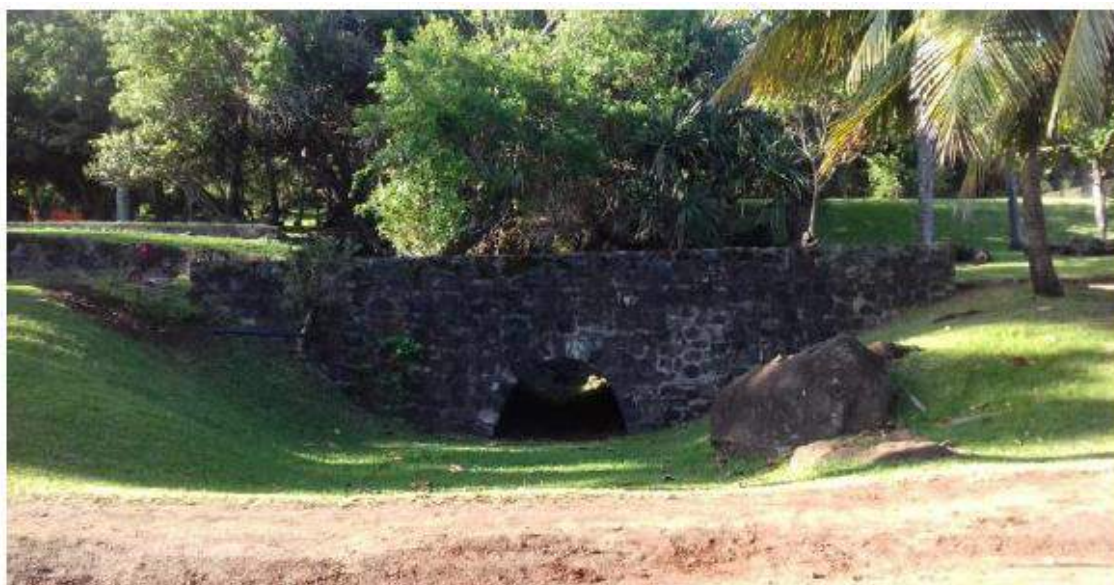
Figure 24: Vue du ponceau sur la petite ravine
