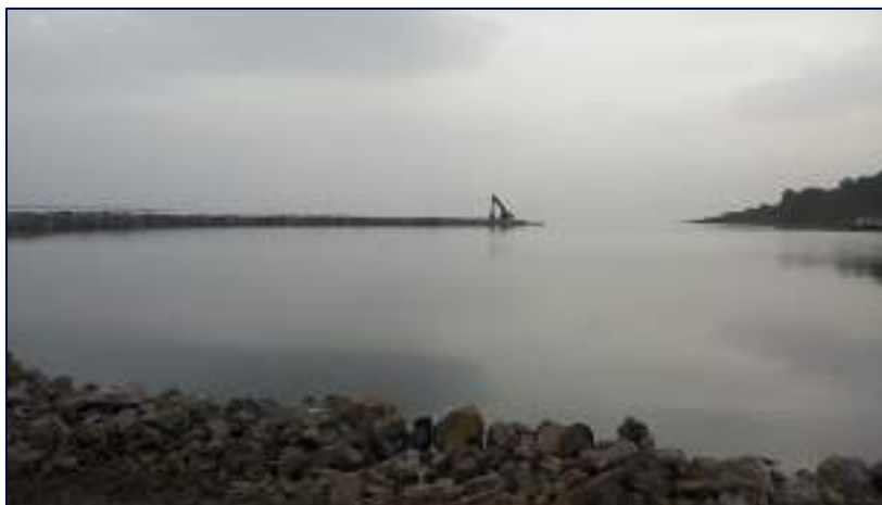
Figure 70 – Exemple de réalisation de digue à l'avancement
