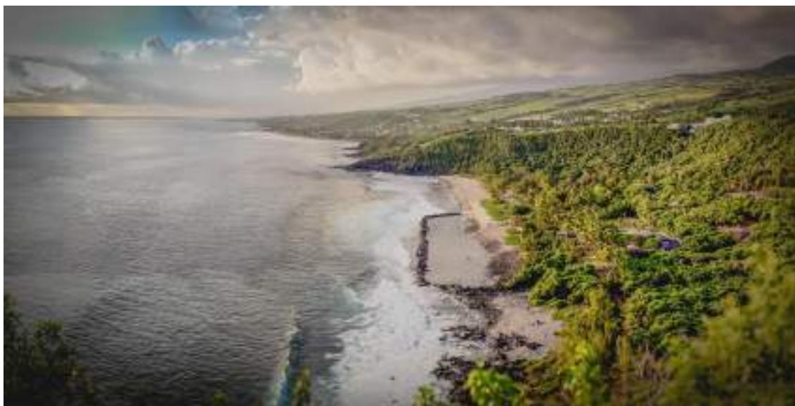
Figure 201 : Visuel initial de la protection en enrochement depuis le Piton Grande Anse
