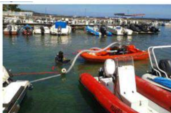
Figure 55 : Exemple de dragage hydraulique en situation de faible tirant d'eau dans le port de Saint Leu
