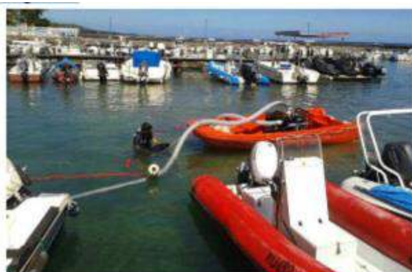
Figure 242 : Exemple de dragage hydraulique en situation de faible tirant d'eau dans le port de Saint Leu
