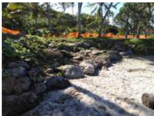
Figure 6: Clichés des boudins cocos et enrochements libres dans le cadre du chantier de l'arrière-plage
