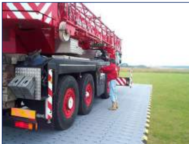
Figure 71 – Exemple de bande de roulement provisoire sans matériaux d'apport
