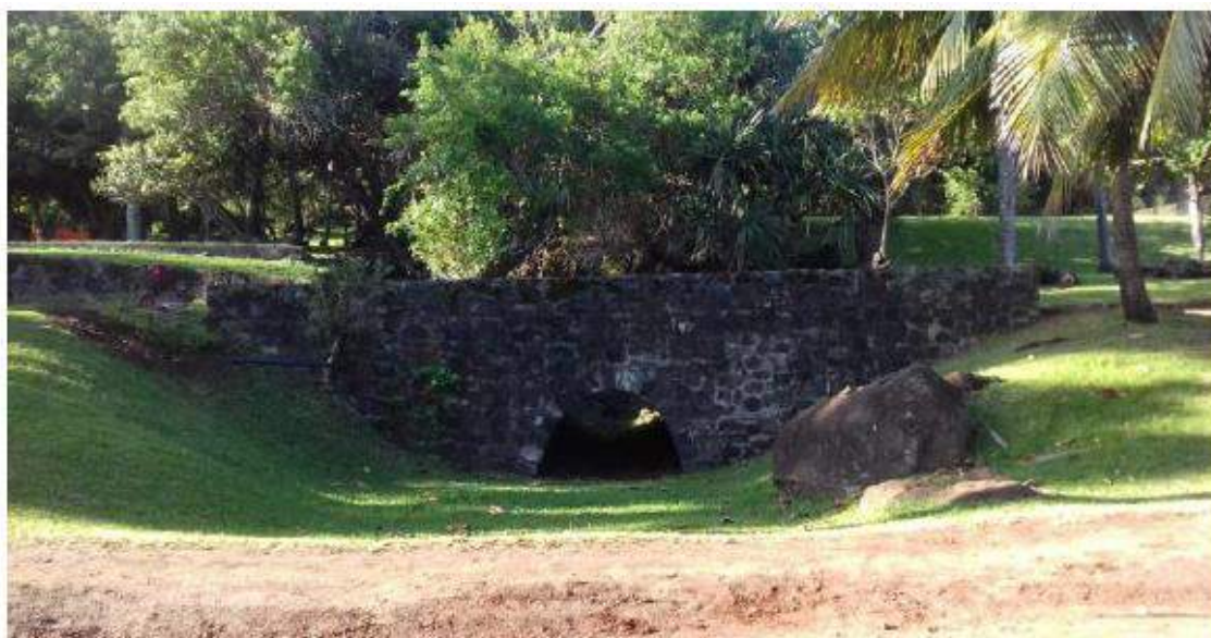
Figure 66: Vue du ponceau sur la petite ravine
