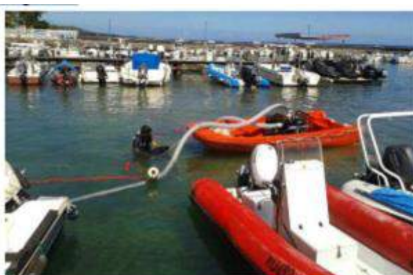
Figure 74 : Exemple de dragage hydraulique en situation de faible tirant d'eau dans le port de Saint Leu
