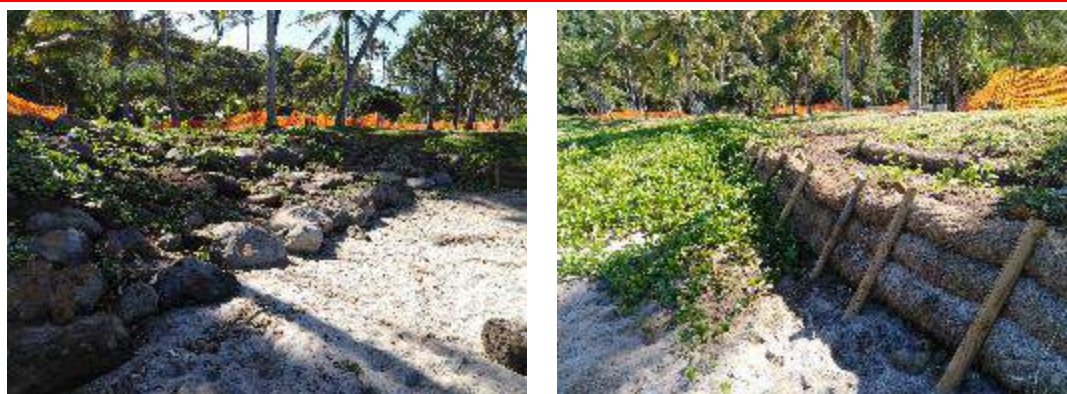
Figure 12: Clichés des boudins cocos et enrochements libres dans le cadre du chantier de l'arrière-plage
