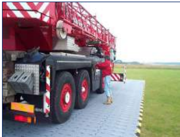
Figure 4 – Exemple de bande de roulement provisoire sans matériaux d'apport
