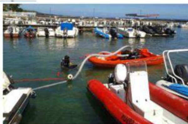
Figure 8 : Exemple de dragage hydraulique en situation de faible tirant d'eau dans le port de Saint Leu
