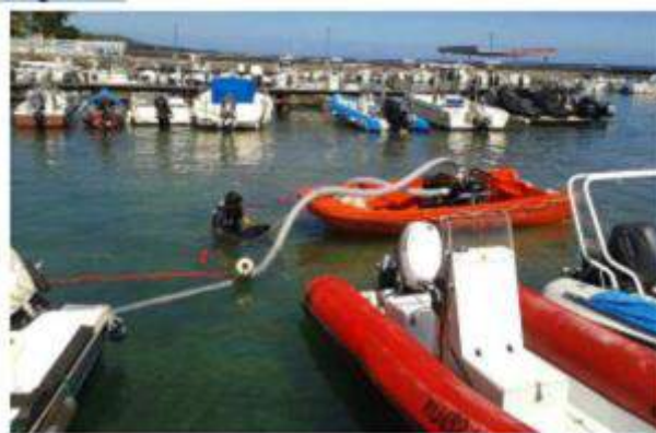
Figure 3 : Exemple de dragage hydraulique en situation de faible tirant d'eau dans le port de Saint Leu
